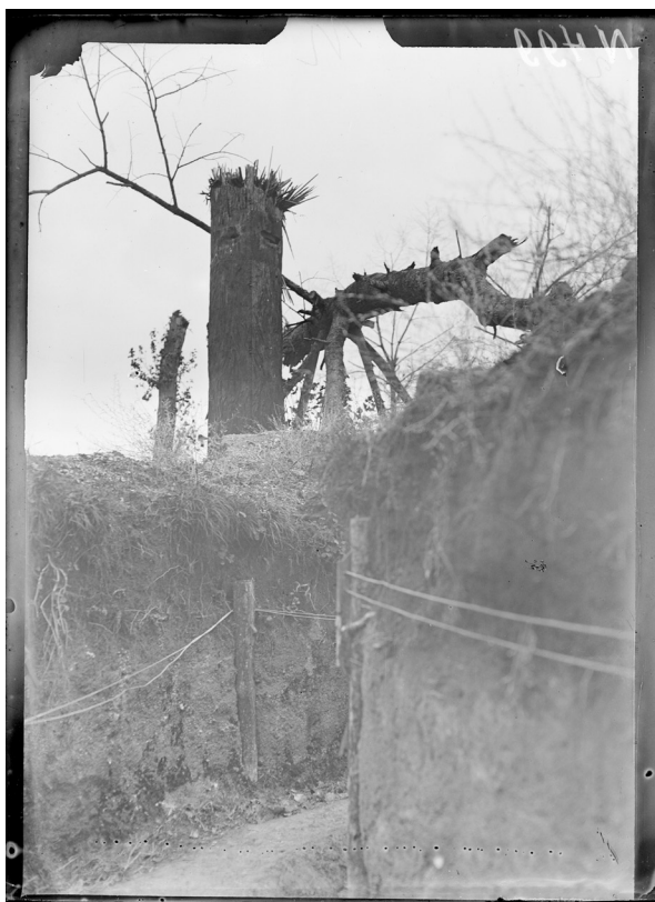
« Région d'Aubérive (Marne), arbre artificiel construit par les camoufleurs pour servir de poste d'observation », photographie, 14 novembre 1916 ECPAD SPA 16 N 499, crédits : Pierre Pansier/Domaine Public/ECPAD/Défense
